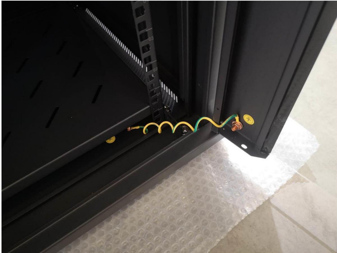
Installation de la mise à la terre de la porte comme indiqué sur l'image.
